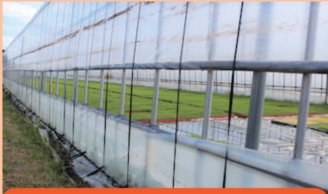
ハウス側面の窓を開けて換気します
